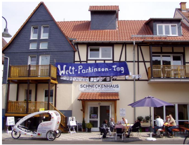
Ein Prachtbau: Das behindertengerechte und mit einem Multifunktionsraum ausgestattete "Schneckenhaus" in Staden verfügt über mehrere Wohnungen, einen Aufzug und einen ebenerdigen Zugang. Archivbild: Lutz
